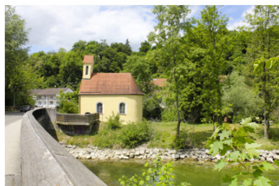
St. Nikolauskapelle an der Amper
