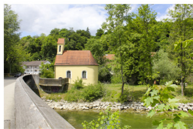
St. Nikolauskapelle an der Amper
